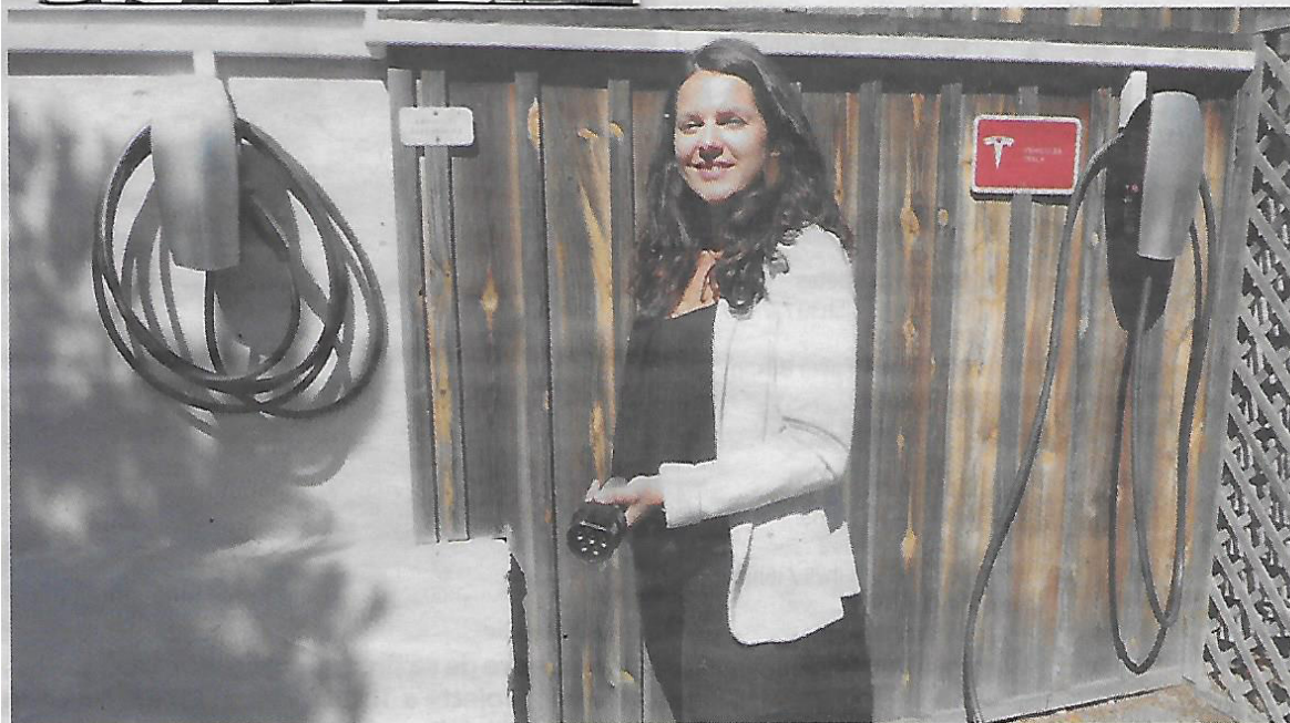
Les premières bornes électrique au Cap-Ferret. PHOTO A. P.
